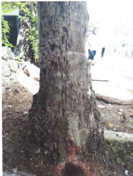
Foto 3. Vista de la base del tronco debilitado y con una ligera inclinación hacia locales cercanos.
